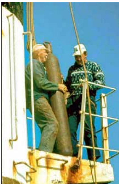
De tunga tuberna förs ut till fyrbalkongen för att krokas i och firas ner.
