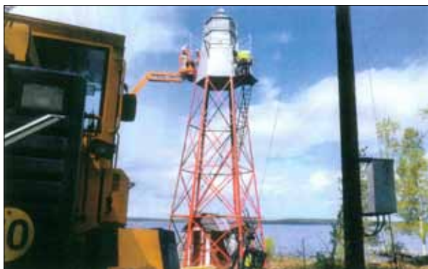
Den skrapade och grundmålade fyren täcks nu med ett första lager vit färg som skall följas av ytterligare två lager. Fotogenhuset har också setts över.
