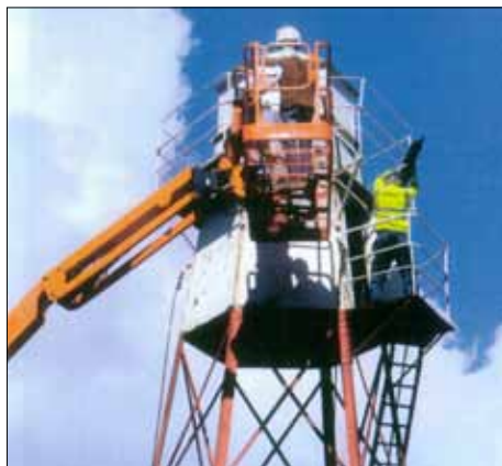
Gångbrädorna runt fyrhuset demonteras.
