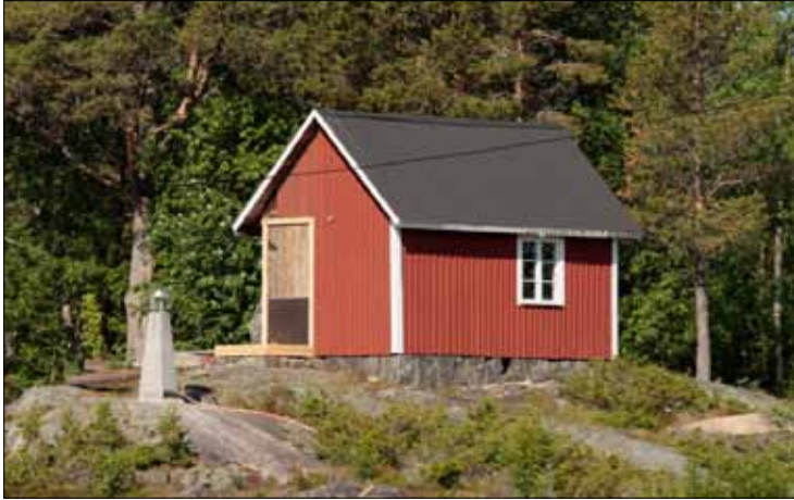
Ratan Södra. Entrén enligt 1874 års ritning förberedd med öppningen in i huset inramad. Bilden tagen från SO. I förgrunden antennen till Lantmäteriets SWEPO:s anläggning. Foto: Peder Öberg
