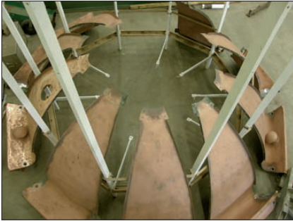
Lanterninens koppartak skall nu poleras och lödas ihop bit för bit.
