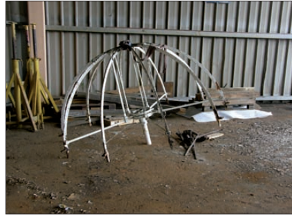
Delar av den nedmonterade lanterninen..
