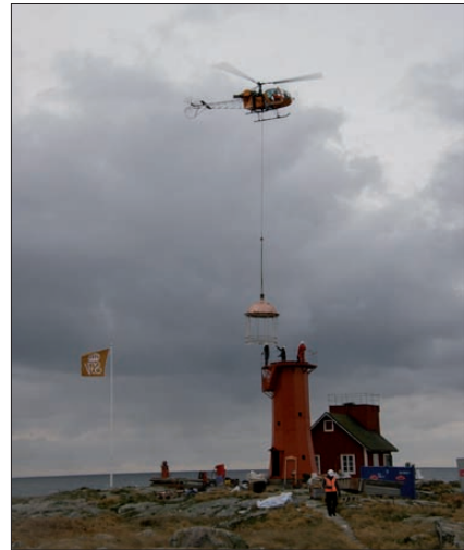
Lanterninen flygs ut för att placeras på Tylöns totalrenoverade fyr.
