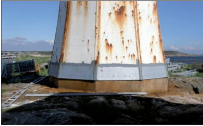
Rostiga plåtar har bytts ut och fyren därigenom säkrats från kollaps.
