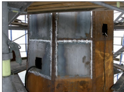
Ytterligare rostiga plåtar fick bytas ut.
