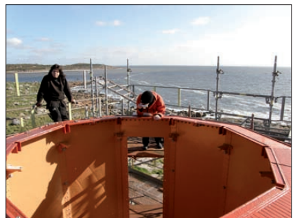
Tylön tömd på sitt innehåll, blåstrad och målad.
