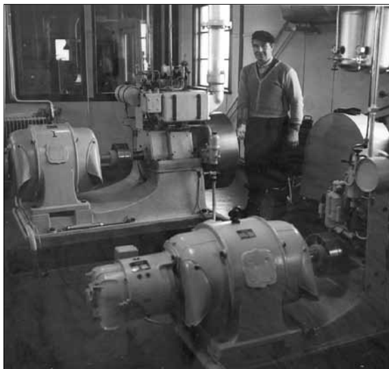
Fyrvaktare Holger Holmgren vid 25 hästars reservkraftverket. Bakom honom syns den inglasade radiohytten för radiofyren, där fanns också kronometern.
