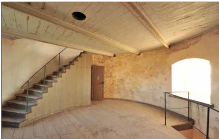
Interiörbild från Östergarnholms gamla fyr. Fyren som totalsanerats från hussvamp.
