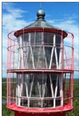
Lanterninen med den unika bi-formade trumlinsen skyddas av en gallerbur.
