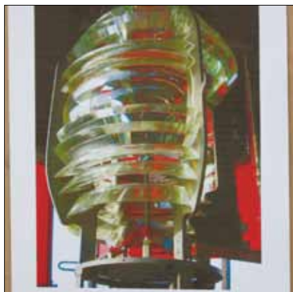
Linsapparaten från Fjuk med krona överst, trumma i mitten och krans nederst. Då det nya fyrtornet byggdes 1909, placerades linsapparaten i lotsstyrelsens förråd. 1937 installerades linsapparaten i Borgholms fyr eftersom brand förstört linsen där. Bilden visar linsen i Borgholms fyr.
