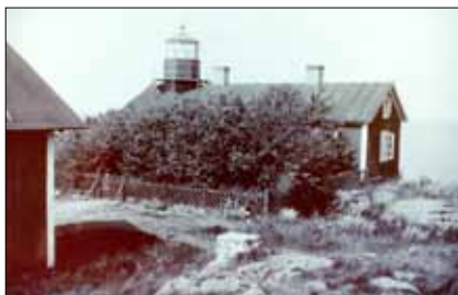
Fyrvaktarbostaden med lanternin. Nu behövede fyrvaktaren inte gå ut i ur och skur för att fylla på fotogen.
