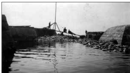
Hamninloppet blockerat av sten efter vinterns stormar.
